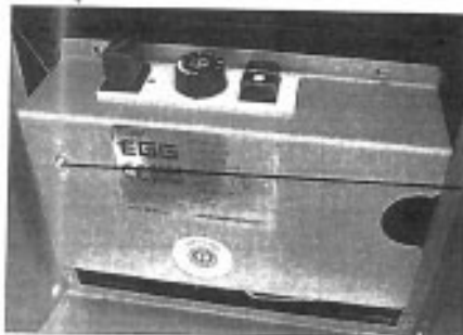
Entriegelungsstift des Sicherheits-thermostates
